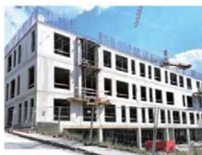
Projektovou dokumentaci připravila kancelář Obermeyer Helika, která byla pověřena také autorským dozorem. Díky zvolenému řešení stavbu posunula do pasivního standardu.
