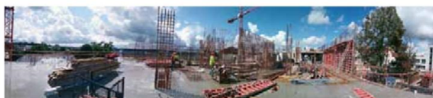
Z průběhu betonáže stropů; příprava pro vertikální nosné konstrukce. Pracovalo se také na hrubých rozvodech vzduchotechniky, elektřiny, topení a medicijního plynu.
